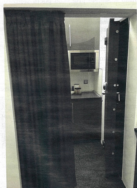
Návrh panikové místnosti od P-KOVO Brno počítá s otevíráním dveří z obou stran
